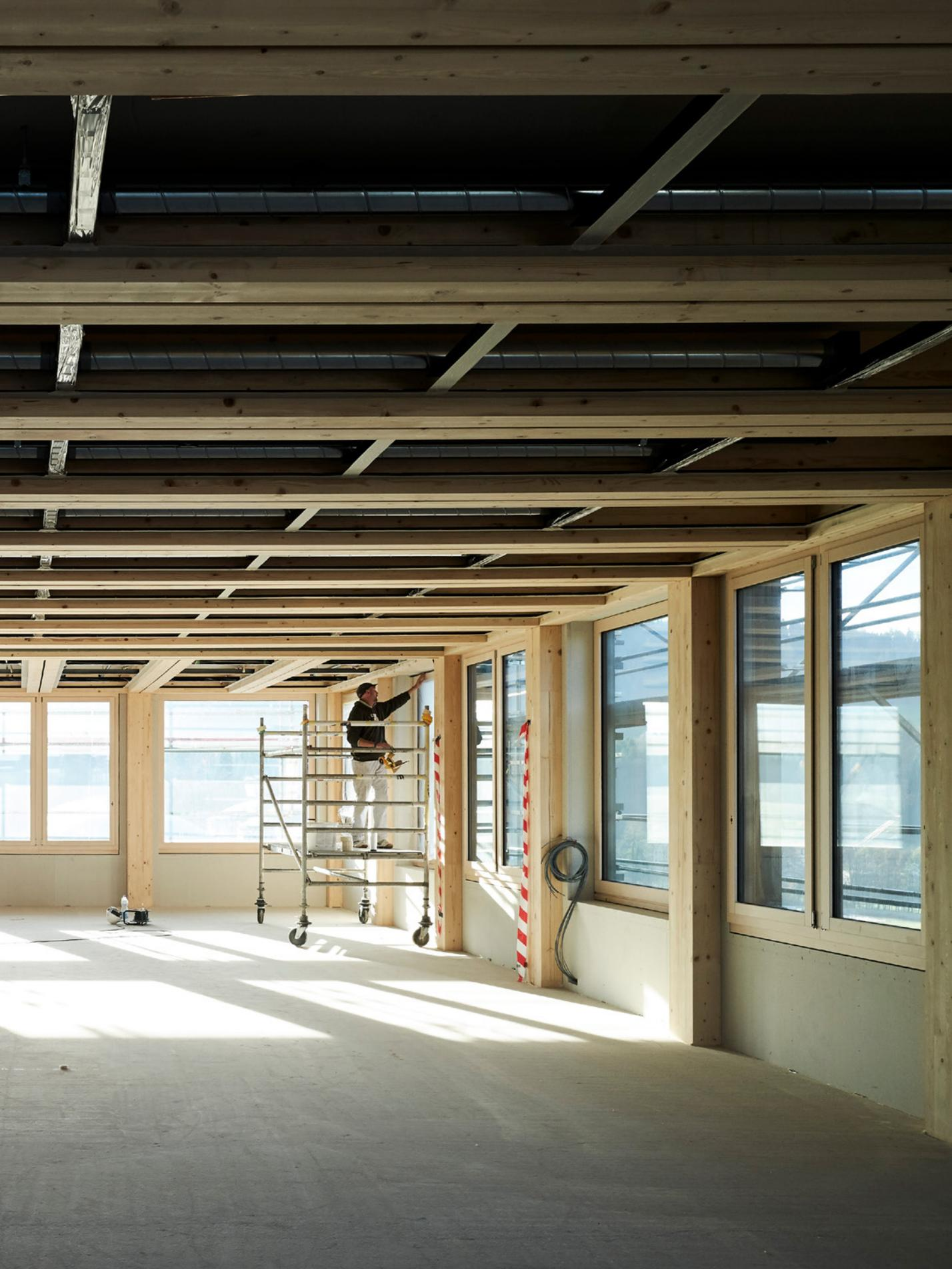
Unter einem Holz-Hybridbau verstehen wir ein Gebäude, dessen Struktur zu einem hohen Anteil aus Holz besteht.
